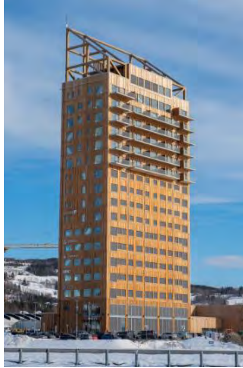
Mjøstårnet (ミョーサ・ノルウェイ) 木造 地上18階建て・85m 2019年竣工
